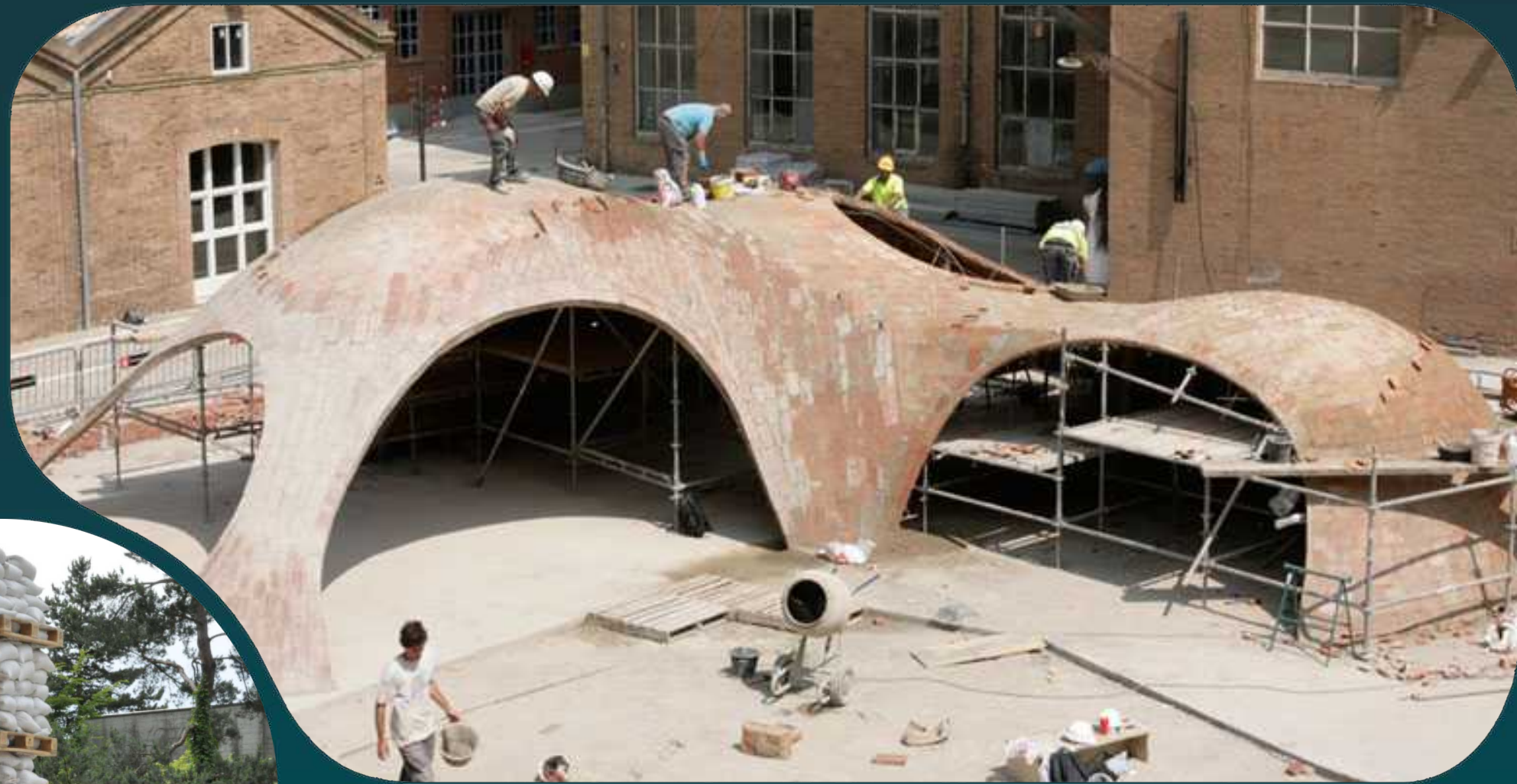
Кровельные оболочки которые работают на сжатие, без арматуры ( от Philip Block Research Group ETH Zurich )
